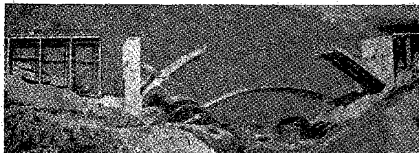
Obr. 15. Vytahování střední skruže
